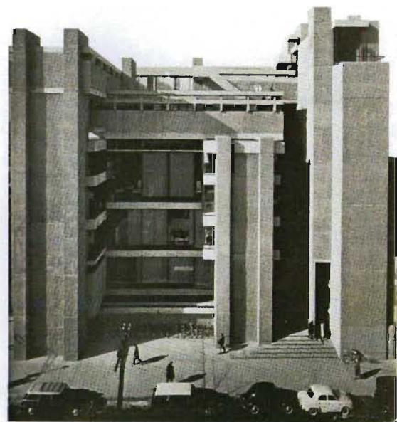
Fig 4.1.11 East (entrance) façade, Schwab: 1970, 125
