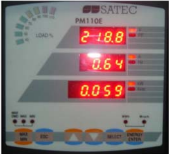
Fig. 4.7 Satec power meter
