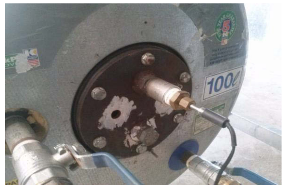
(d) Thermocouple on water tank
